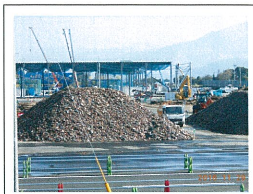
手前は廃瓦、向こうは混合廃棄物ライン
