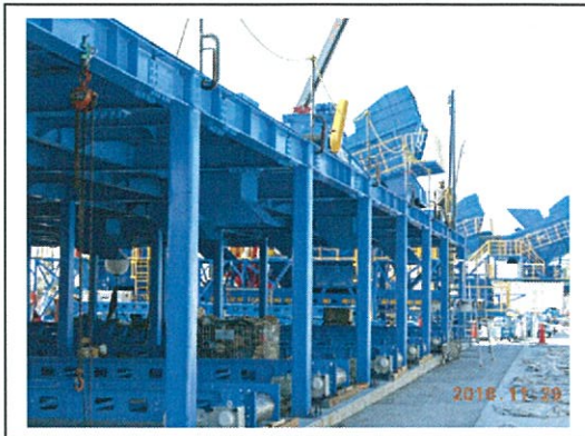
建設工事中の混合廃棄物処理ライン
